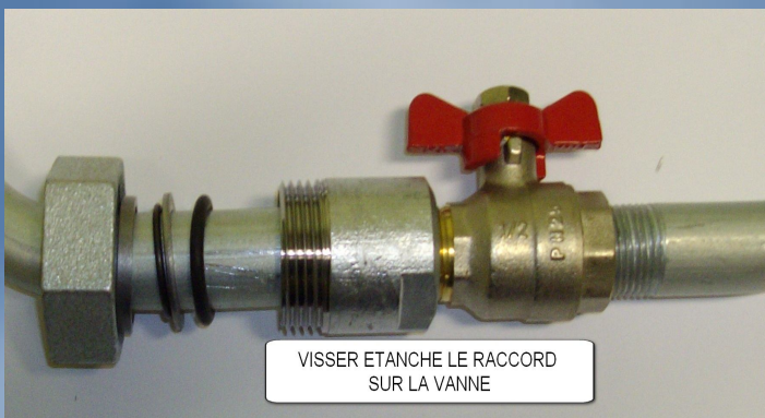
MONTER LES ACCESSOIRES DU RACCORD SUR LE TUBE LISSE
