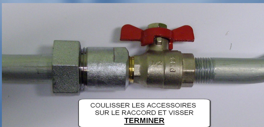
VISSE ETANCHE LE RACCORD SUR LA VANNE
