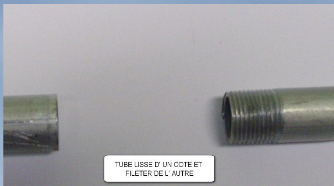
CHANGER UNE VANNE DEFECTUEUSE MONTÉE EN ENFILADE
